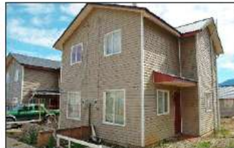
PIONERAS. — Las 70 viviendas del conjunto "18 de noviembre", de Cuyhaique, tienen un sistema de aislación térmica con lana de vidrio en los muros.
